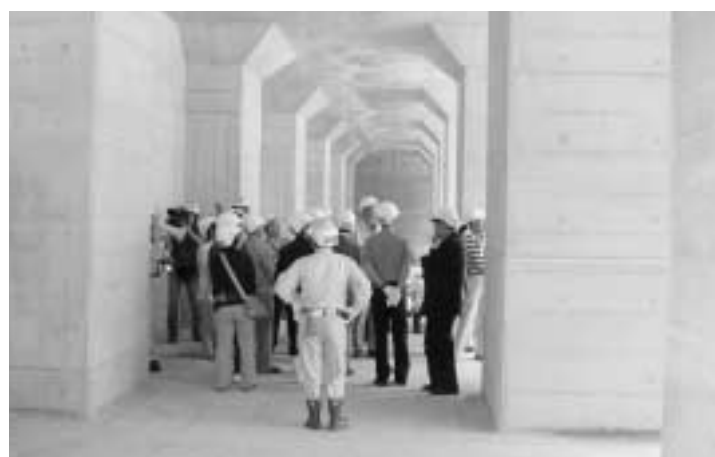
地下遊水地構内
