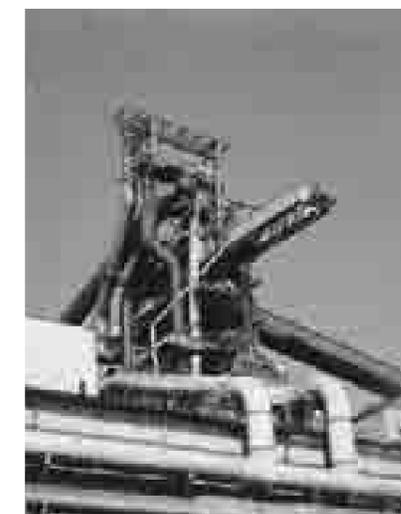
京浜地区では使用済みプラスチックを処理し、コークスの代わりに高炉の還元材とするシステムを世界で初めて採用しました
