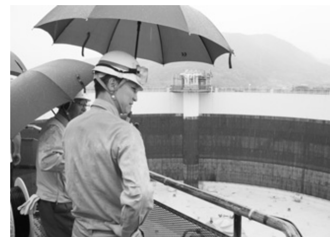
地中タンクに昇り、タンクの蓋を見下ろす様子
