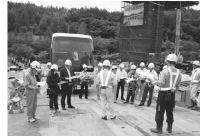
「楓橋」工事現場で見学の説明を受けている様子
