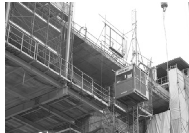
橋梁上上がるエレベーター
