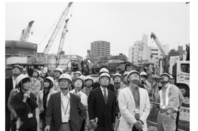
建設中のタワーを見上げる様子
