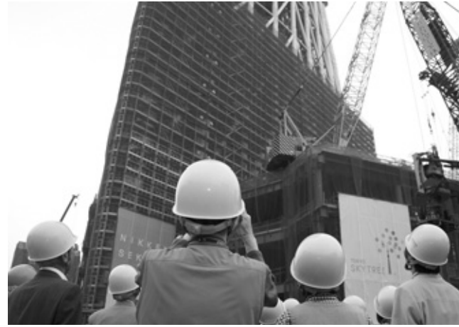
建設中の東京スカイツリー
