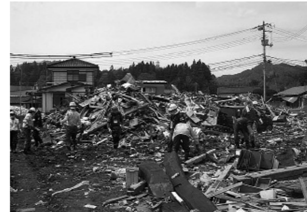
被災地でのがれき撤去作業
