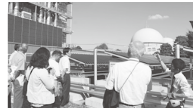
参加者の正面は太陽熱集熱器。左側のB館壁面には太陽光発電パネルが設置
