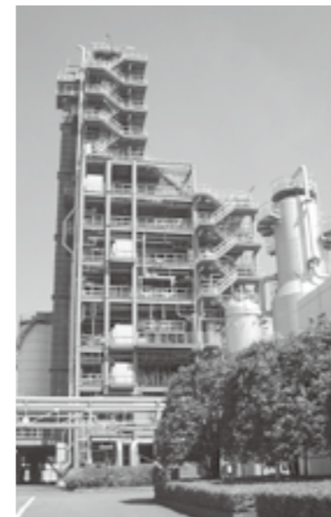
巨大なガス化設備
