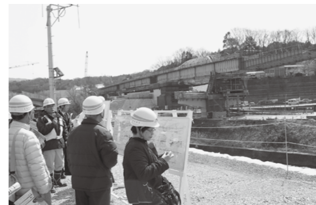
重連式送り出し工法で鋼桁が架設される様子を見学
