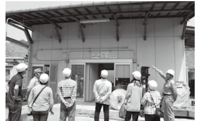
四方を土手に囲まれた火薬製造工場
