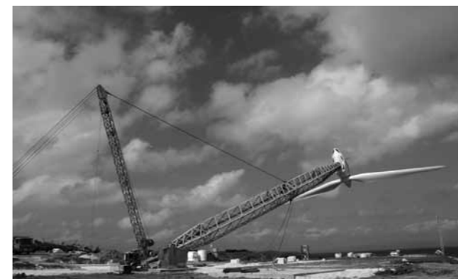
可倒式風力発電設備傾倒時（写真提供 沖縄電力）
