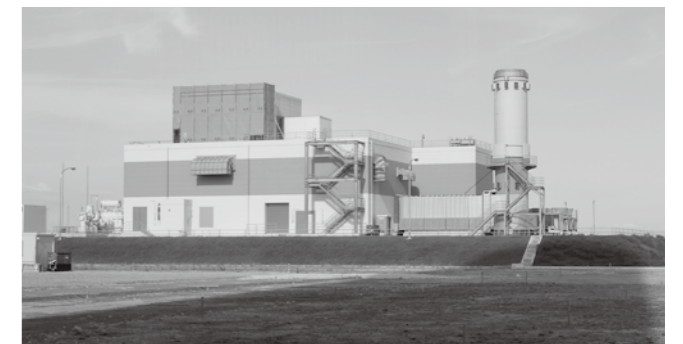
吉の浦マルチガスタービン発電所
