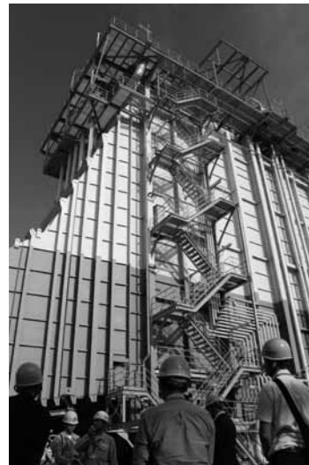
排熱回収ボイラを見学
