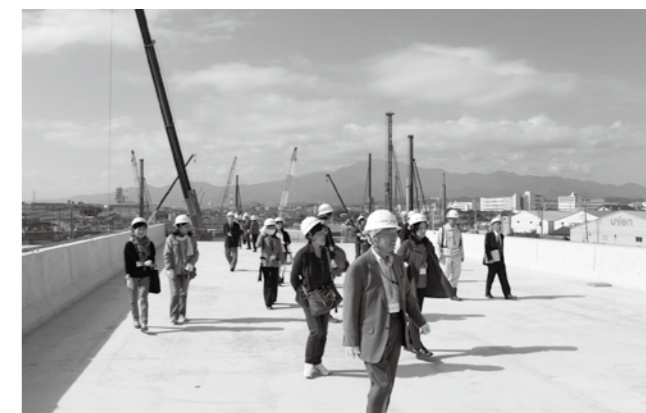
建設中の高速道路を歩く
