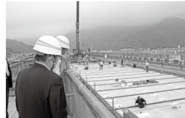
説明を聞きながら迫力あるリニューアル工事を見学
