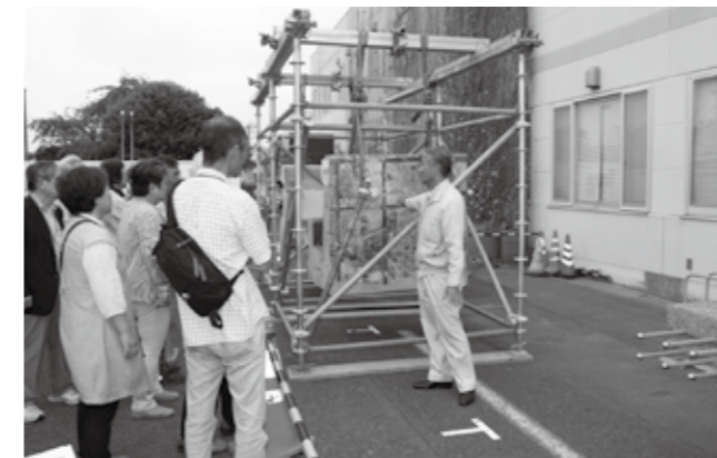
撤去した古い床版の一部を間近に見てその大きさを改めて確認
