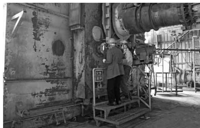
ガラス窓よりロータリーキルン内をのぞき込む
