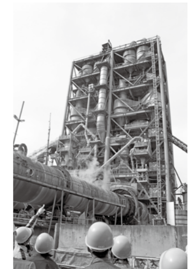
手前の円形の筒がロータリーキルン奥の設備がプレヒーター
