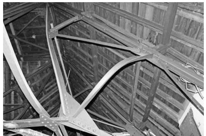
戦災により曲がった屋根裏の鉄骨
