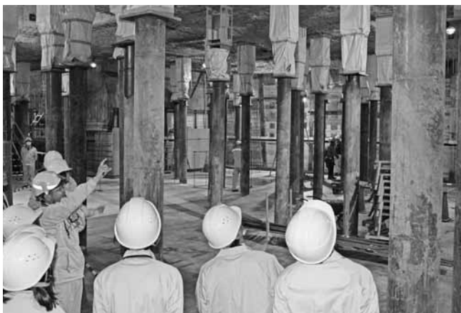
無数に鋼管杭が立ち並ぶ地下空間
