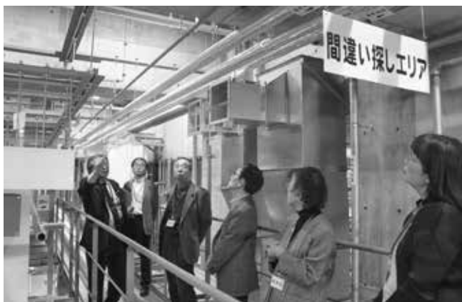
間違い探しエリアで正誤の施工例を対比
