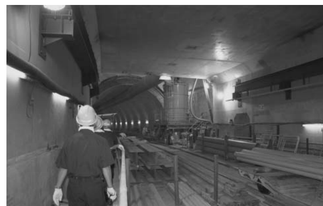
工事中の新宿三丁目駅 手前側（北側：池袋方面）が開削工法、奥（南側：渋谷方面）がシールド工法
