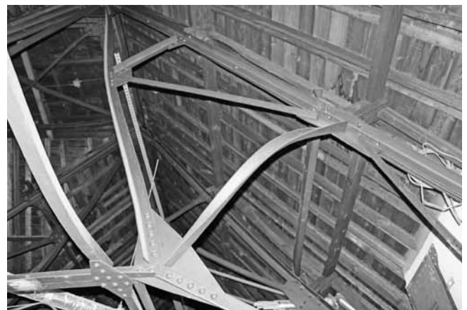
戦災により曲がった屋根裏の鉄骨
