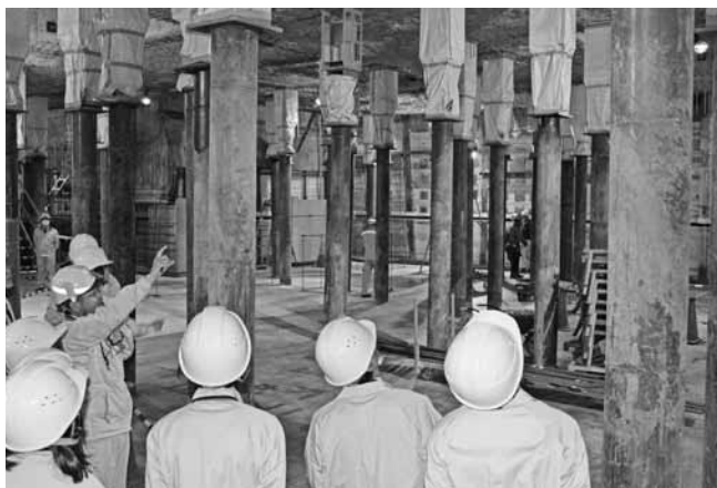
無数に鋼管杭が立ち並ぶ地下空間
