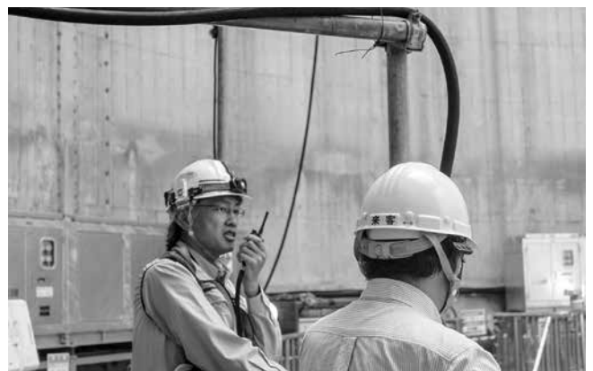
副所長より工事現場の説明
