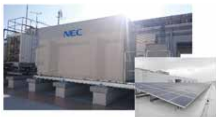
自社ビルに設置した業務用蓄電システム
