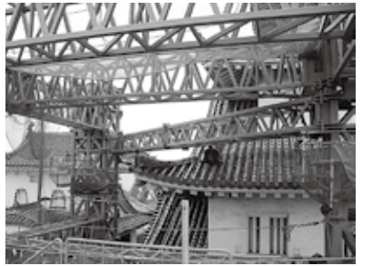
複雑に張り巡らされた鉄骨（鹿島建設提供）
